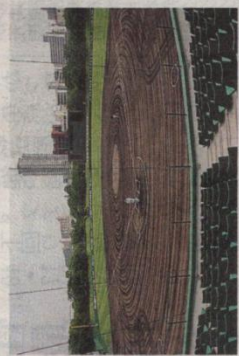
改修が進められている明石トーカロ球場
